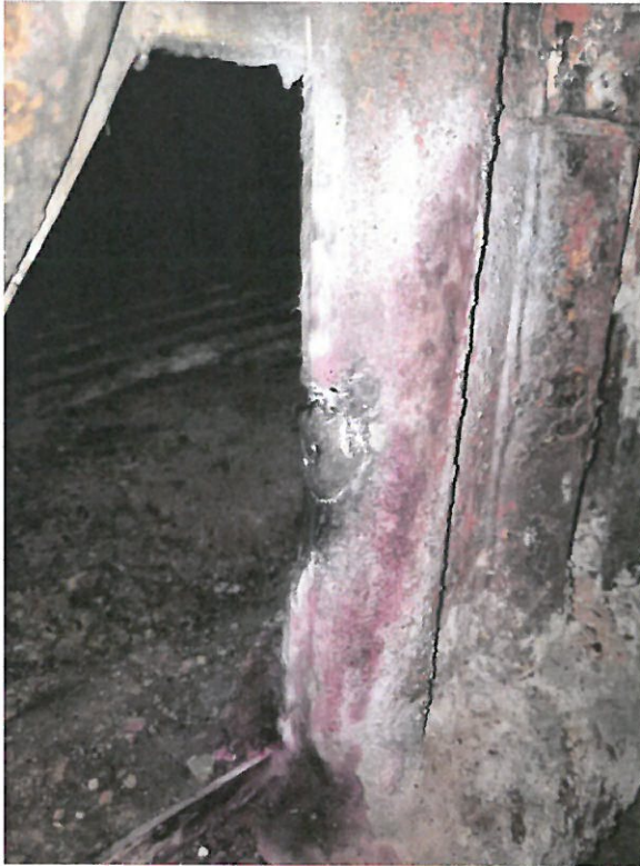
锅炉水冷壁管 W1
