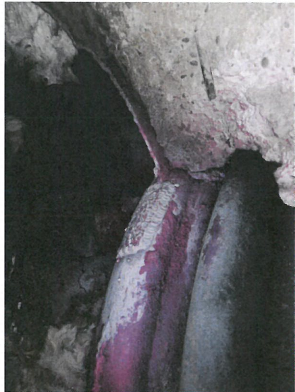
锅炉水冷壁管 W2
