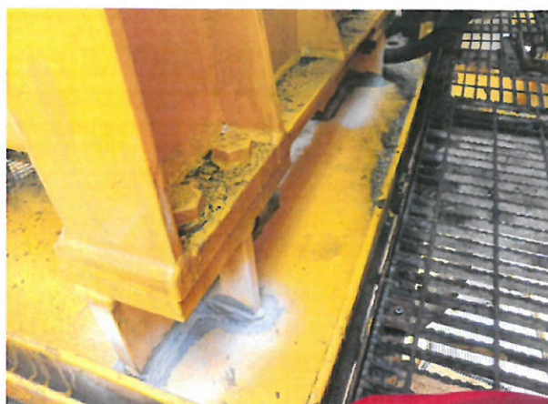
变幅绞车试重后 2
