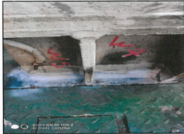
井架支座 3 号 W4 W5 (应力测试前)
