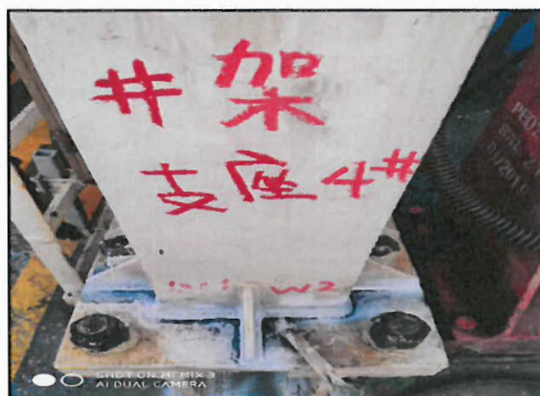
井架支座 4 号 W1 W2 (应力测试前)
