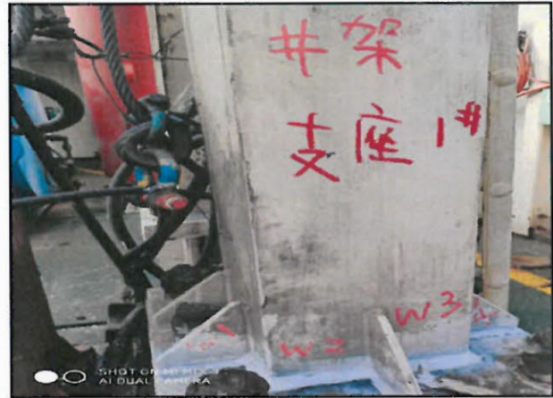
井架支座 1 号 W1 W2(应力测试前)
