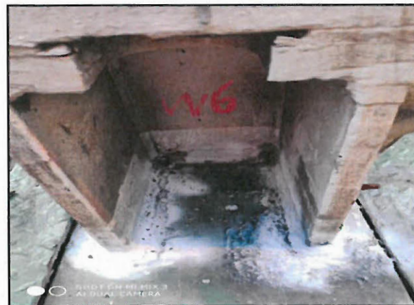
井架支座 3 号 W6 (应力测试前)
