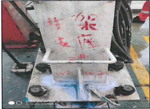
井架支座 3 号 W1 W2(应力测试前)
