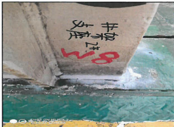
井架支座 2 号 W8 (应力测试前)
