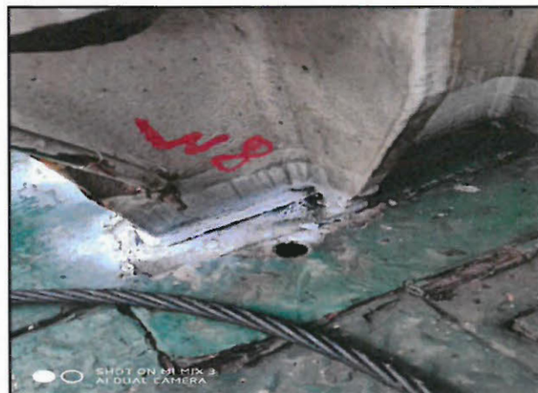
井架支座 4 号 W8(应力测试前)
