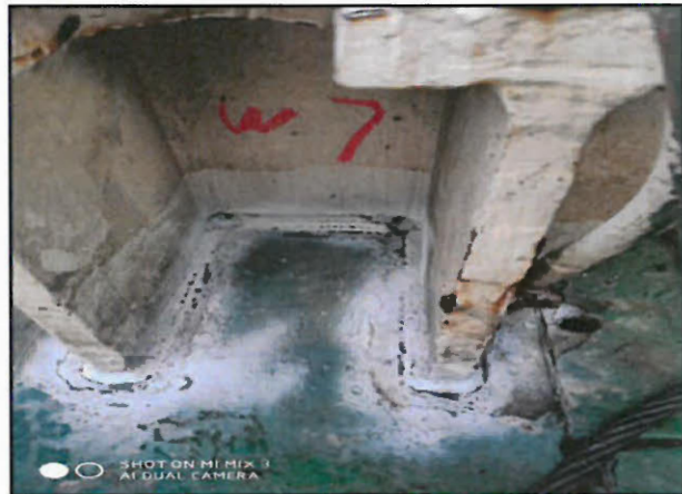
井架支座 4 号 W7 (应力测试前)
