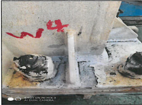
井架支座 4 号 W4 (应力测试前)
