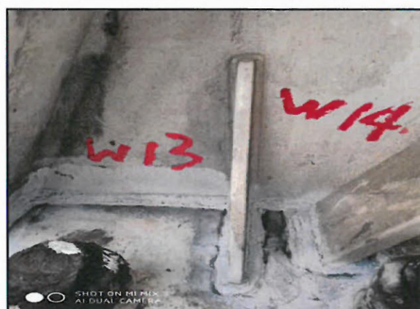
井架支座 2 号 W13 W14(应力测试前)
