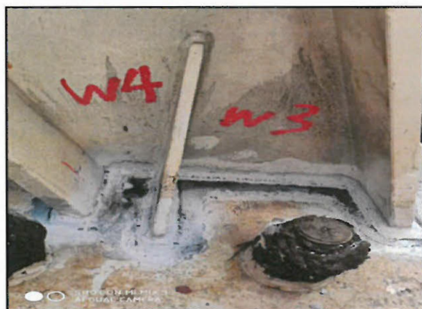
井架支座 2 号 W3 W4(应力测试前)
