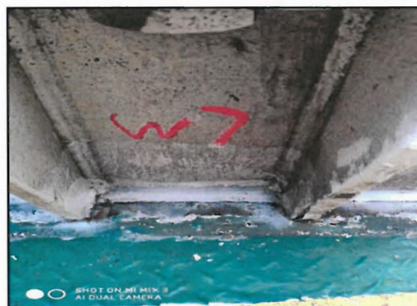
井架支座 2 号 W7 (应力测试前)
