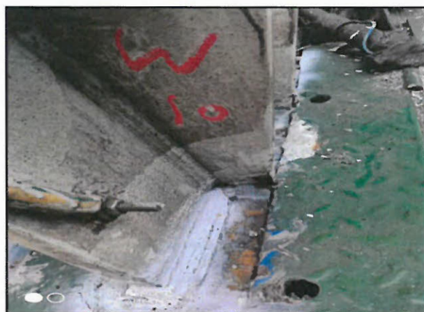
井架支座 2 号 W10 (应力测试前)
