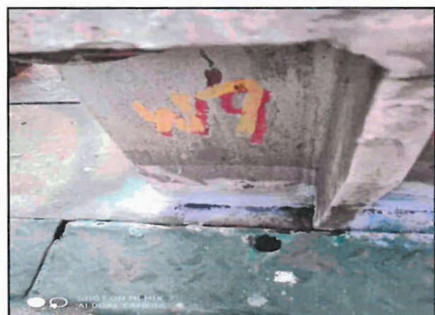
井架支座 3 号 W7(应力测试后)
