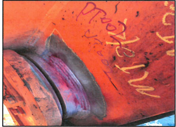
1#吊机 MT002 局部
