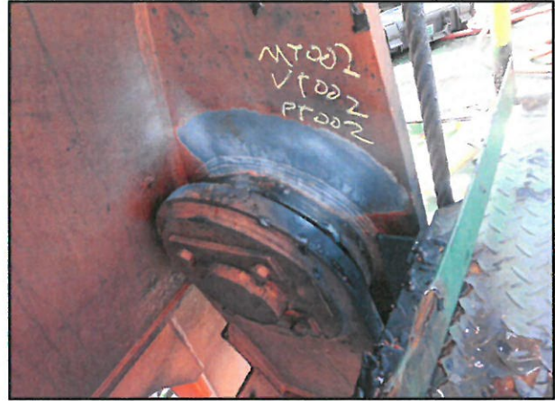
2#吊机 MT002 局部
