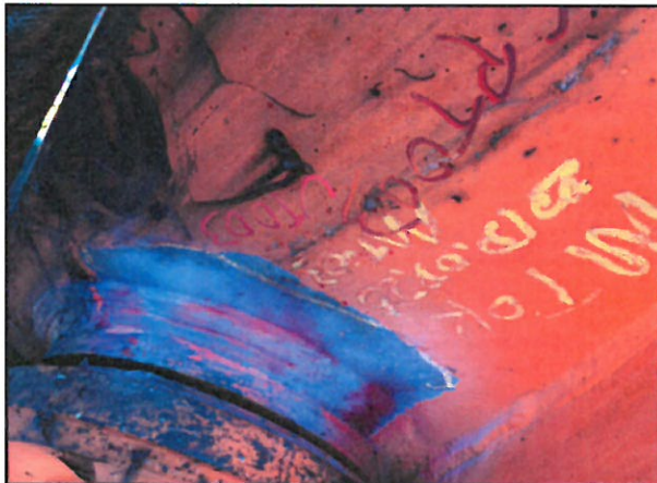
1#吊机 MT003 局部
