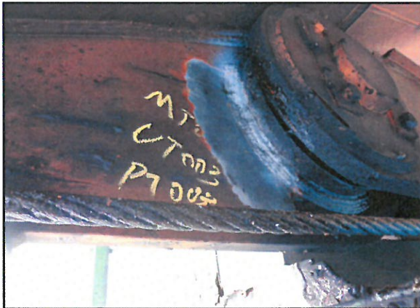
2#吊机 MT003 局部
