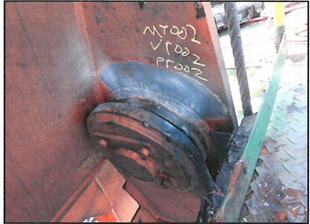
2#吊机 UT002 局部
