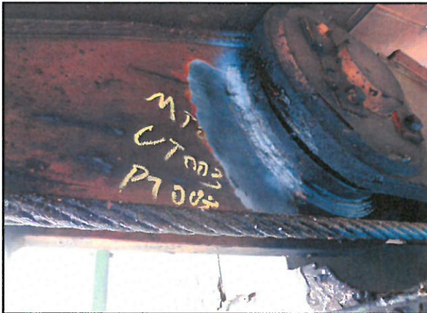
2#吊机 UT003 局部
