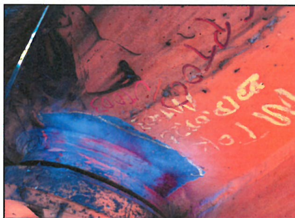
1#吊机 UT003 局部
