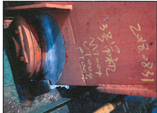
2#吊机 UT004 局部
