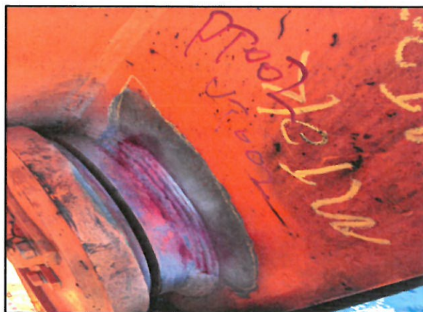
1#吊机 UT002 局部
